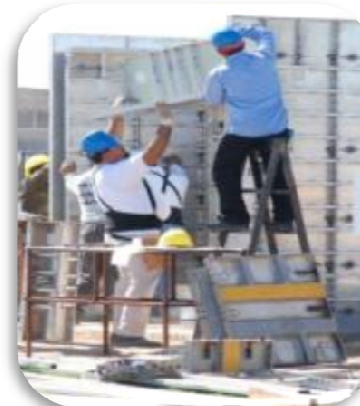
Armado del molde
