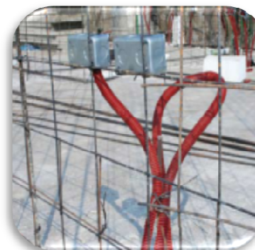
Instalaciones Hidráulicas, Alcantarillado y Eléctricas.
