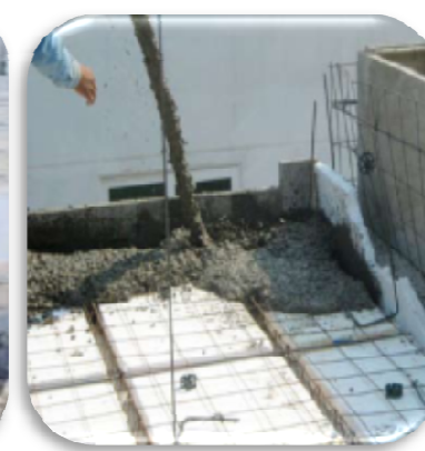
Colado del molde.
