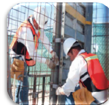
Colocación de discos separadores de acero
