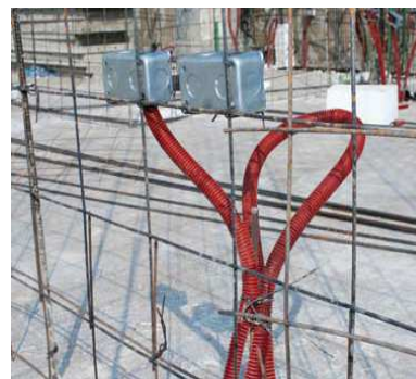
Instalaciones Hidráulicas, Alcantarillado y Eléctricas.
