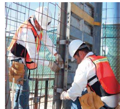
Colocación de discos separadores de acero
