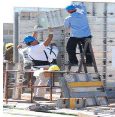
Armado del molde
