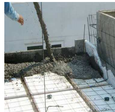
Colado del molde.
